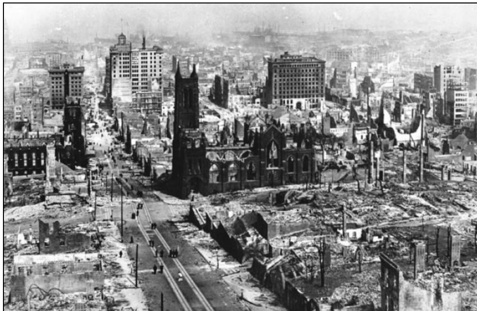
Последствия землетрясения в Сан-Франциско
